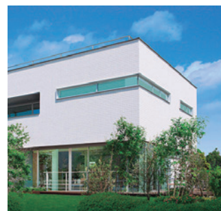
Pametna kuća. Ariake, Tokio. HVAC i kombinacija proizvodnje solarne energije, gorivih ćelija i baterija za pohranu energije.
