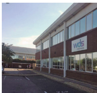
Rekonstrukcija pozivnog centra. Woodhouse Environmental Services Ltd. Bourmemouth, UK. VRF
