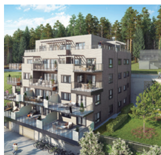
Novi kondominij. Kompleks Bergås Terrasse. Drammen, Norveška ECOi / Aquarea
